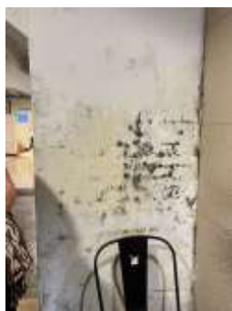
Gambar tersebut menunjukkan salah satu contoh tembok yang lembab di Pos Bloc Sumber: Diambil oleh Penulis
